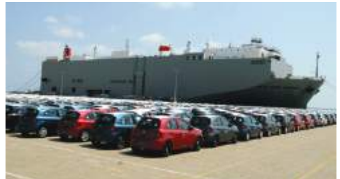
Ro Ro cum General Cargo Berth
